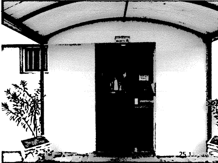
FOTO 17- HALL DA ENTRADA
