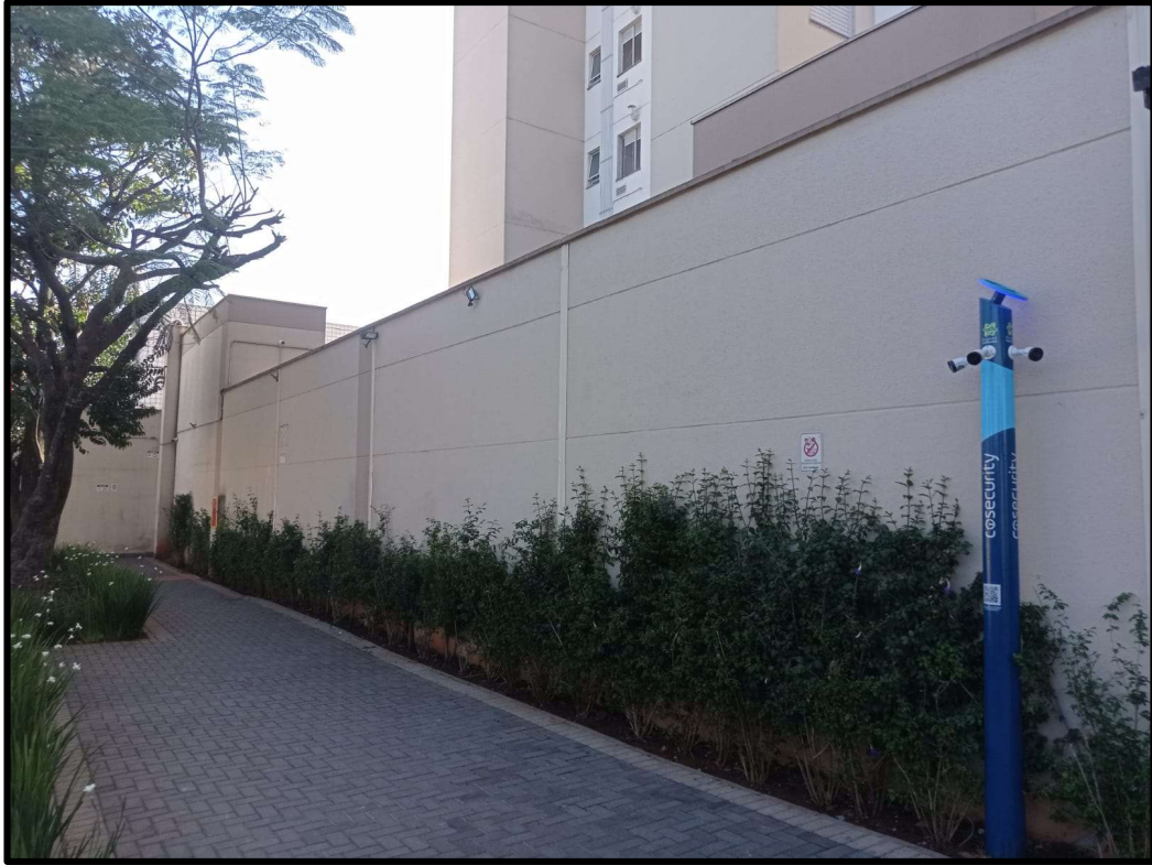
Muro frontal do Condomínio Residencial Dez Vila das Belezas.
