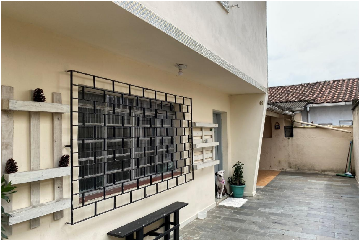
FOTO 04 - Vista parcial da fachada externa e o pavimento térreo da unidade avalianda.
